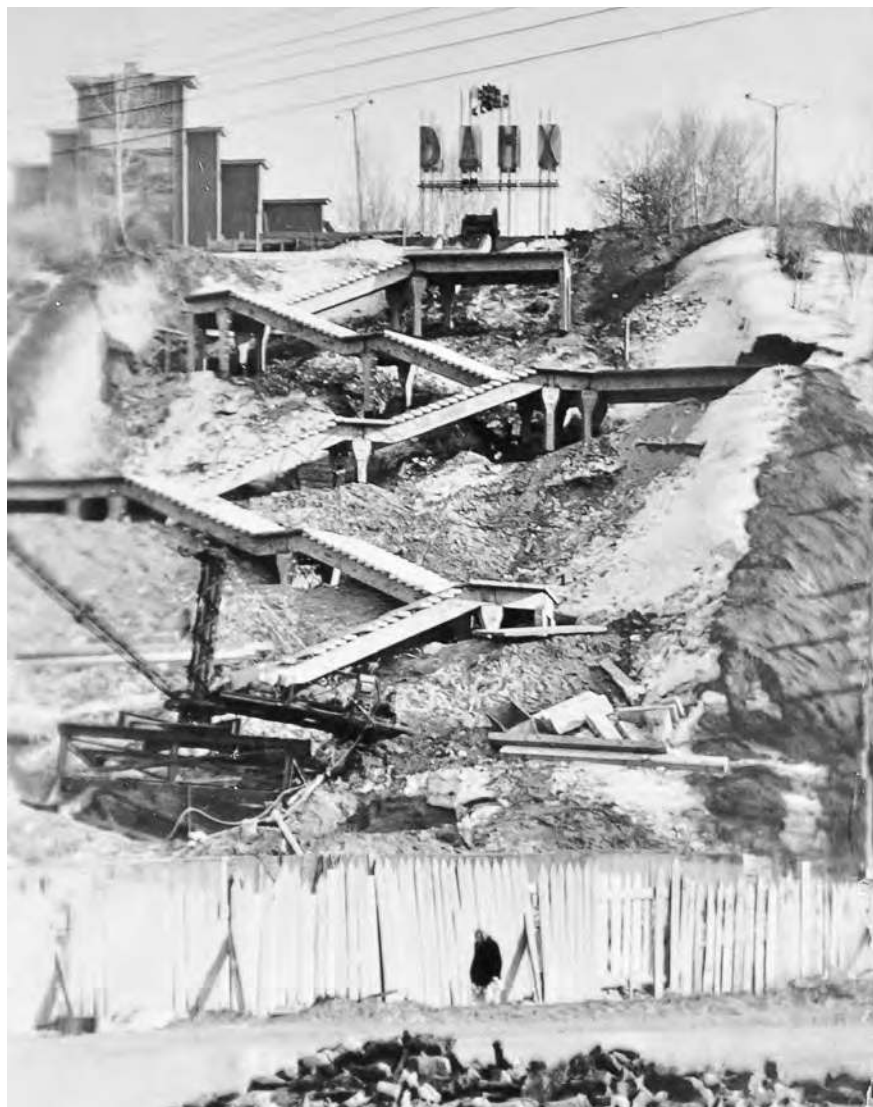
Строительство лестницы на ВДНХ по проекту Виктора Казаринова
